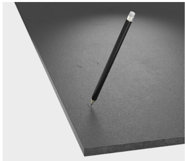
Beim Anzeichnen darauf achten, dass die Markierung kleiner ist, als das Befestigungsmittel
